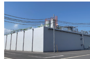
フジボウ愛媛大分工場 排水処理設備
