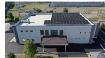
フジボウ愛媛壬生川工場 技術開発棟
