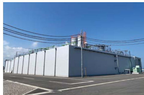
大分工場廃水処理設備
