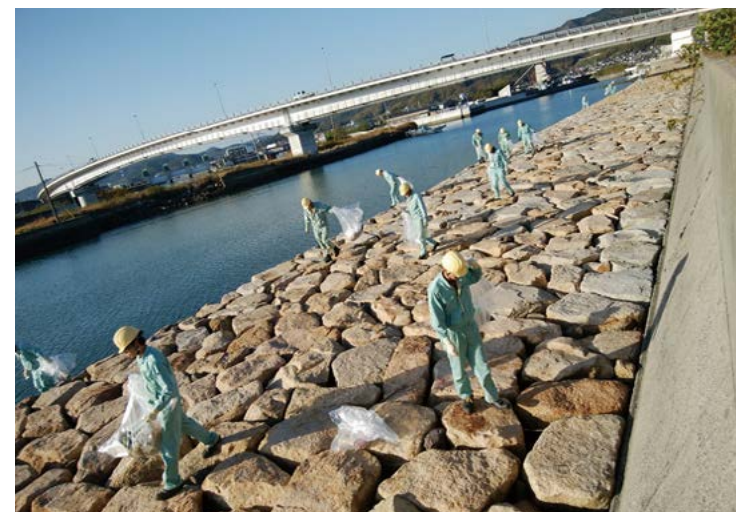
柳井本社工場護岸清掃
