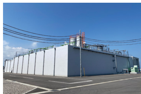
大分工場廃水処理設備
