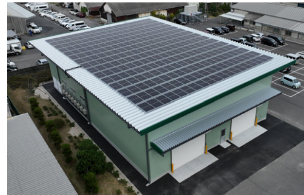
上空から見たZEB設計の倉庫
