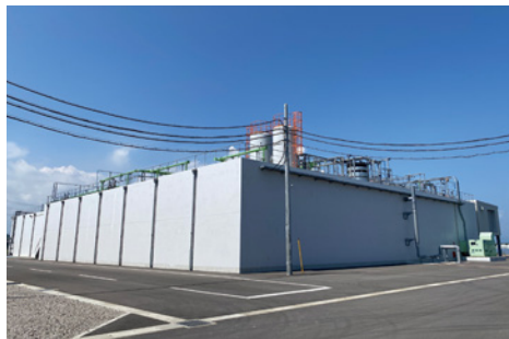
大分工場廃水処理設備
